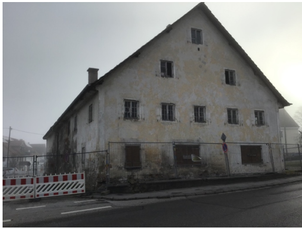
Nördliche Fassade des Bestandsgebäudes
