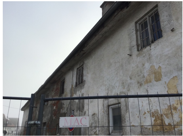
Östliche Fassade Bestandsgebäude
