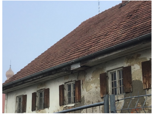
Dachbereich der westlichen Fassade des Bestandsgeb#udes
